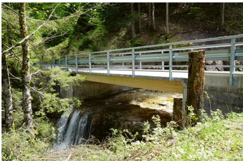
Ansicht der fertigen Brücke
