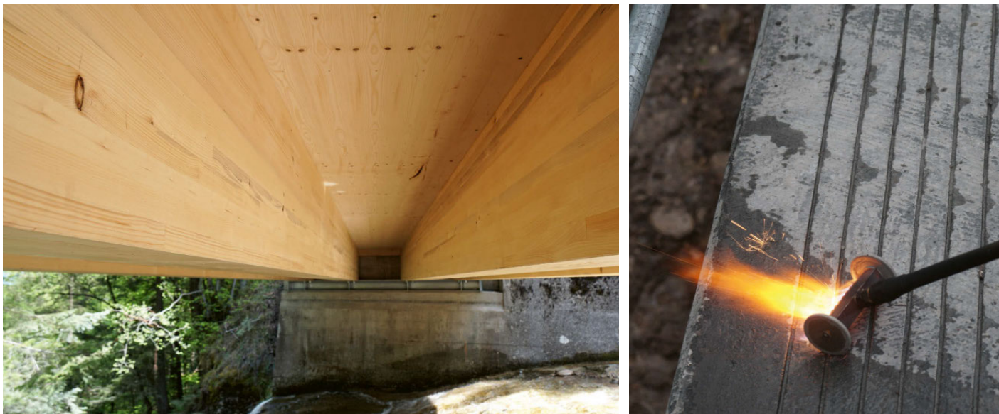
Brückenansicht von unten und von oben: Die Rutsicherheit der Fahrbahn wird mit eingefrästen Rillen sichergestellt. Dadurch abstehende Stahlfasern werden anschliessend abgeflammt.
